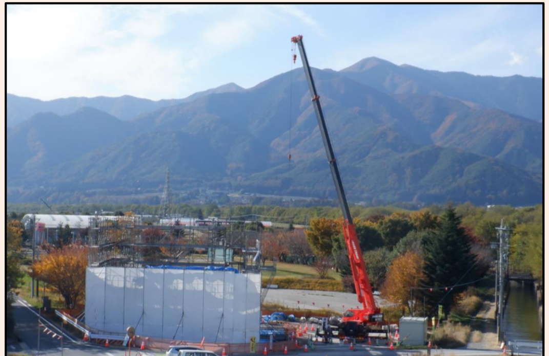
【扇子田高架橋(工事中) 橋台(西側)】
