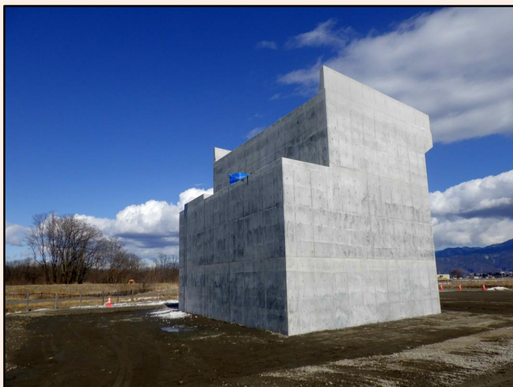
【扇子田高架橋(完成) 橋台(東側)】 南から北を望む
