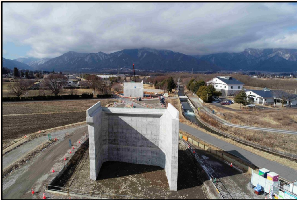
【扇子田高架橋(完成) 橋台全景】
