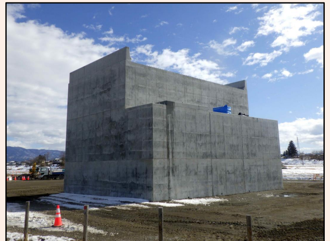
【扇子田高架橋(完成) 橋台(東側)】 北から南を望む
