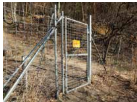
⑬ 鳥獣被害防止防護柵 ゲート
