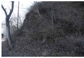
① 落石防護施設
