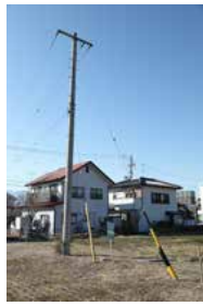
② 電柱と支線
