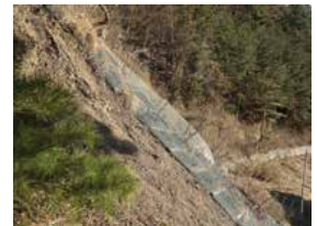
⑯ 落石防護施設
