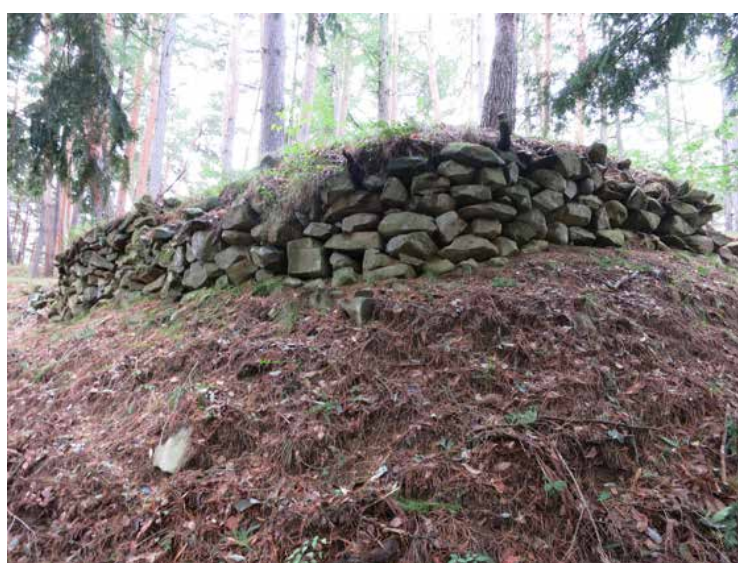
主郭の石積角部 隅角部を造らず円形に積まれている。
