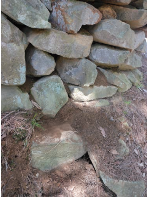
石積を支持する土台石（アゴ止め石状）
