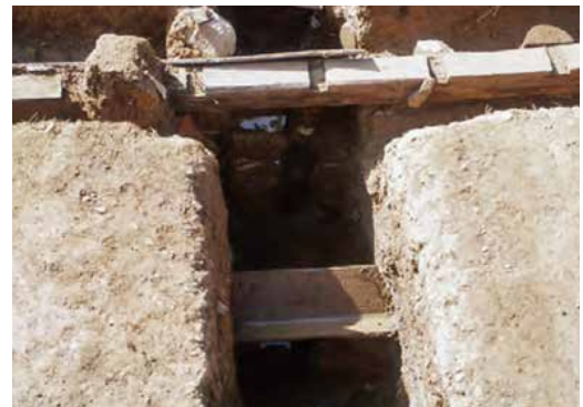
半地下工場屋根基部材(上)と床付近の部材(下) (林山腰遺跡)
