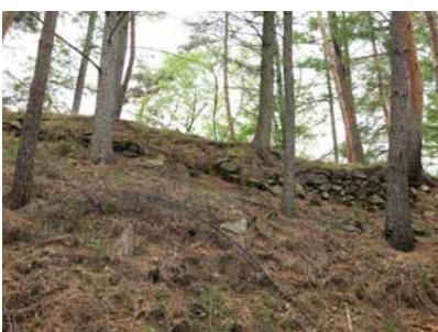
⑦：主郭東側石積（南）
