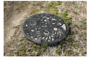
④ マンホール
