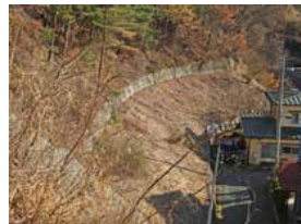
⑭ 落石防護施設
