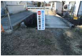
① 通行禁止看板・ 街区表示板
