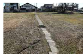
⑳ 畦畔ブロック (里道)
