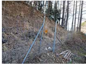
① 鳥獣被害防止防護柵 ゲート
