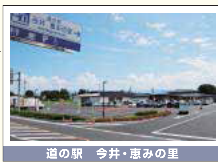
道ノ駅 今井・恵みの里 平成21年8月開設。農産物直売施設・食堂・多目的ホールも併設。
