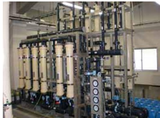
図 6-1 膜ろ過浄水施設
