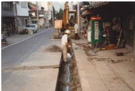
横沢下町配水管布設替工事(昭和54年)
