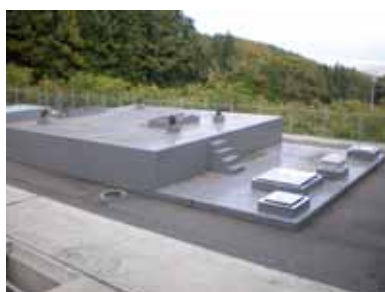
金松寺配水地
