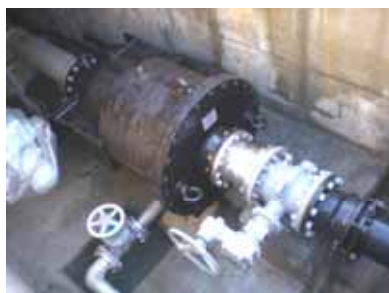
下金井流量調整所(流量調整弁)
