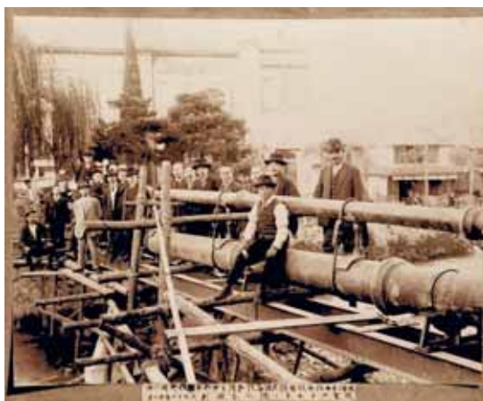
大正 12 年当時の管路布設工事
