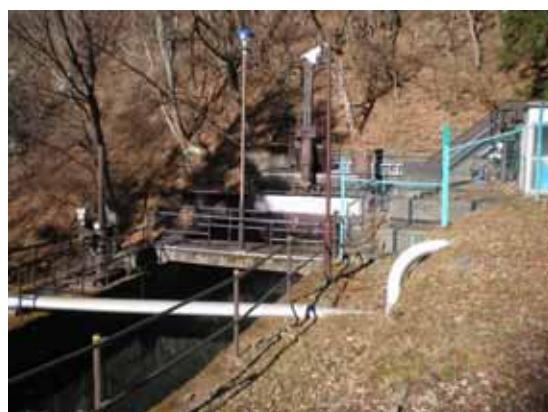
ずい道入口(黒川水源・一の沢、二の沢接合) (平成 9 年改修)
