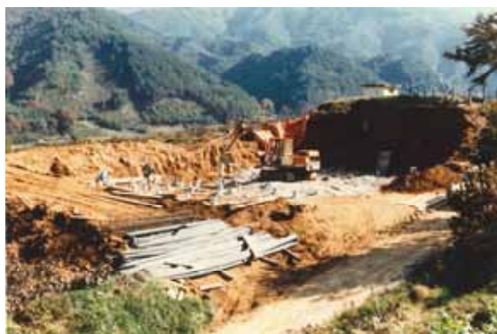
金山低区配水地着工時(昭和57年9月)
