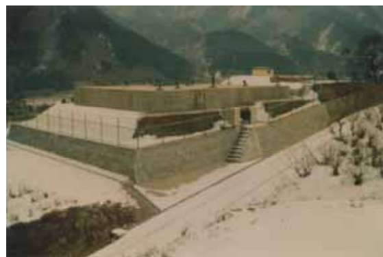
金山低区配水地竣工時(昭和58年1月)
