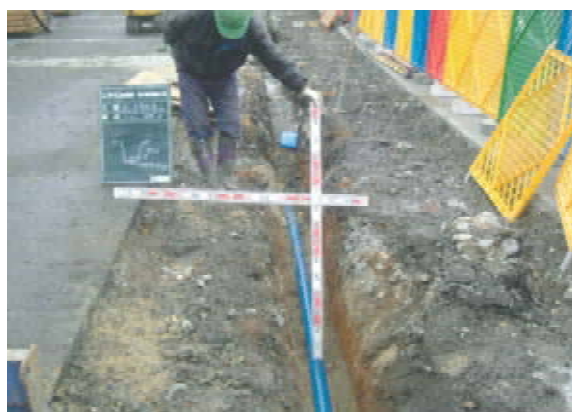
波田駅前配水管布設替工事（平成 21 年）
