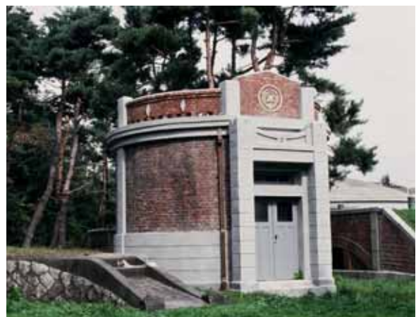
水道創設当時から存在する城山配水地
