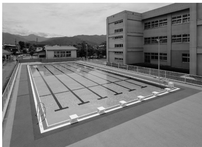
鎌田小学校プール改築
