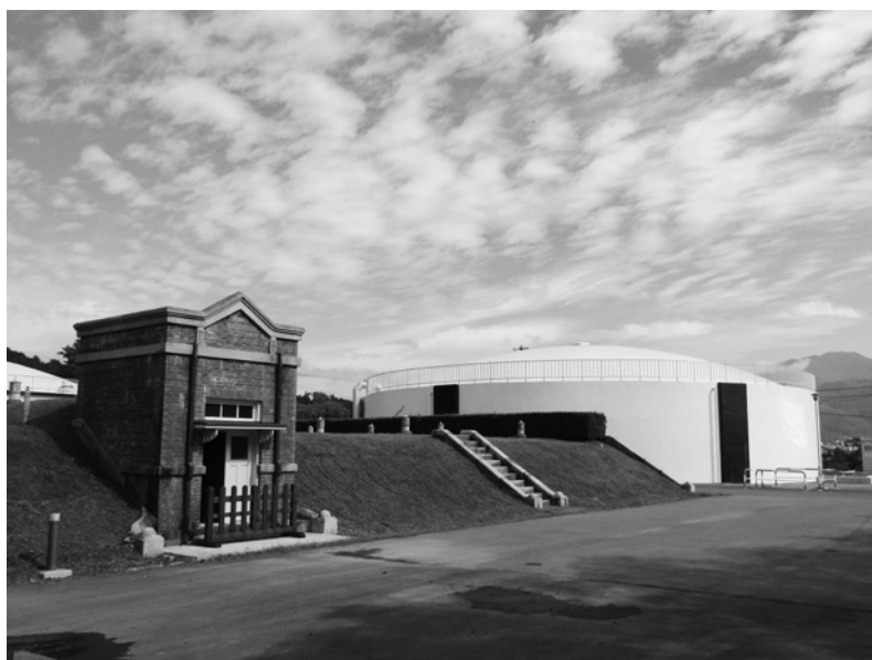
城山配水地新旧配水池
