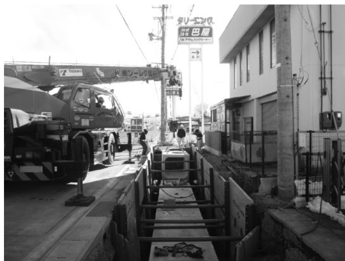
雨水渠整備・穴田川第三雨水幹線
