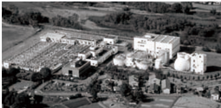
〈両島浄化センター〉
