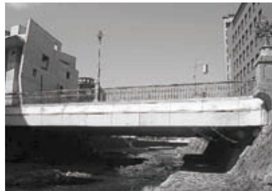
〈橋りょうの長寿命化・千歳橋〉
