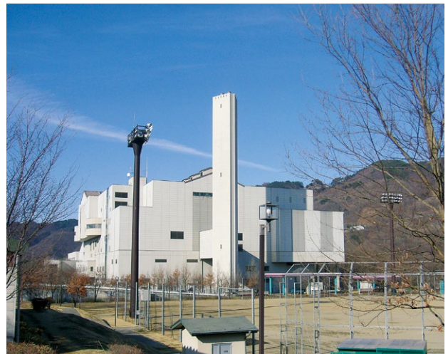
松本クリーンセンター
