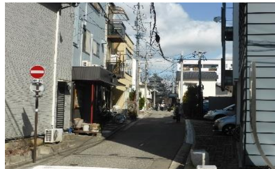
電線類による景観の阻害
