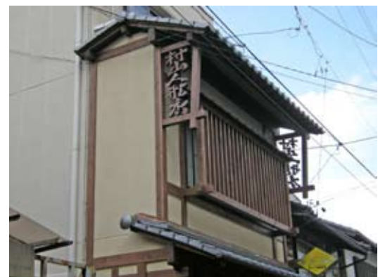
通りのイメージにあわせたファサード（看板建築）に一体化された透かし彫りサイン
