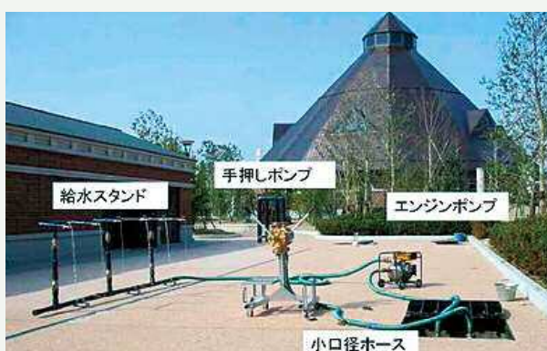
郡山市 耐震性貯水槽
