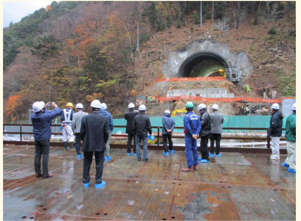
大白川仮棧橋から奈川渡2号トンネルを望む
