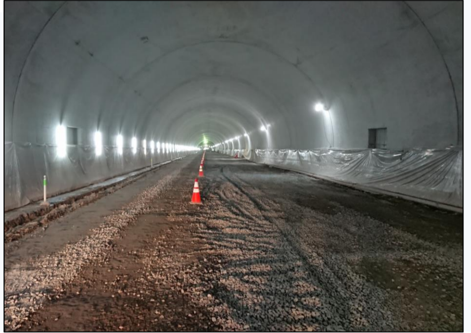
トンネル内部の様子(R2年1月現在)
