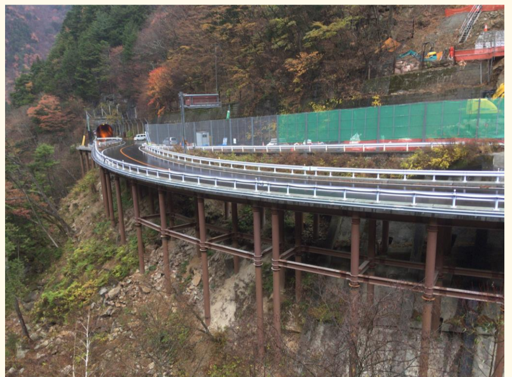
国道158号の付替道路
