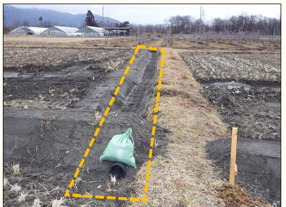
【仮用排水路設置状況】
