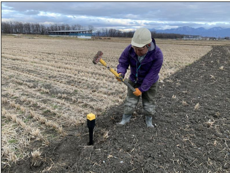
【幅杭復元作業】
