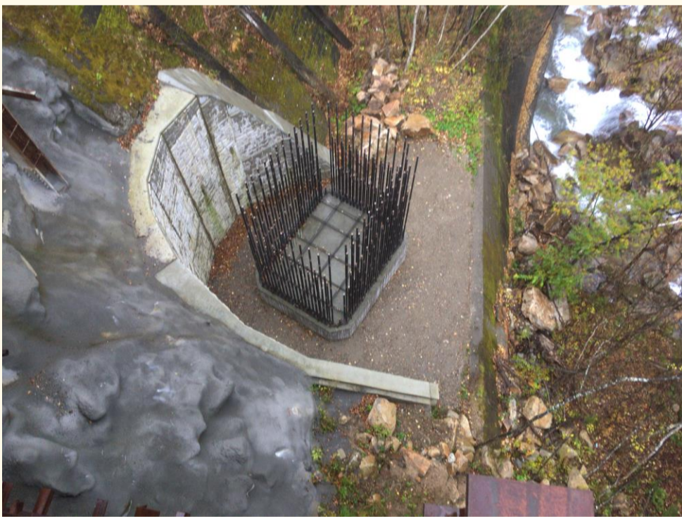
大白川仮棧橋から橋梁下部工
