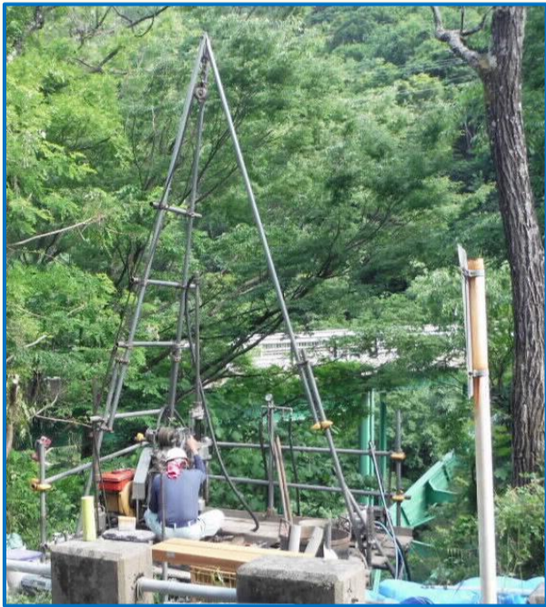
稲核橋付近での地質調査の様子
