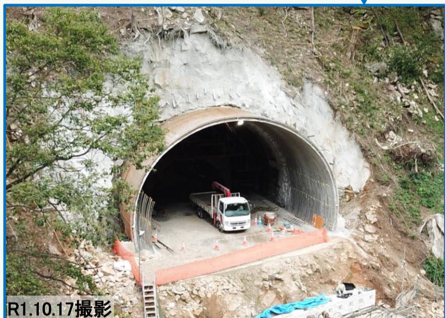
外から見たトンネル出入口
