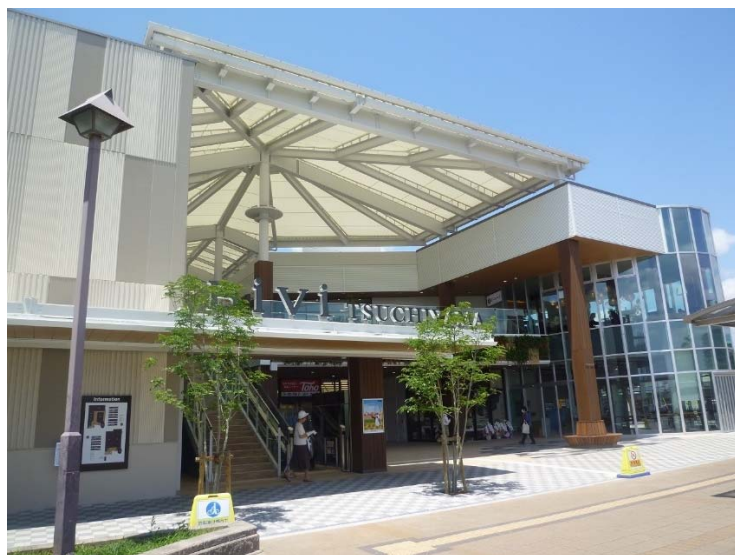
外観（民間商業施設：Bivi土山）
