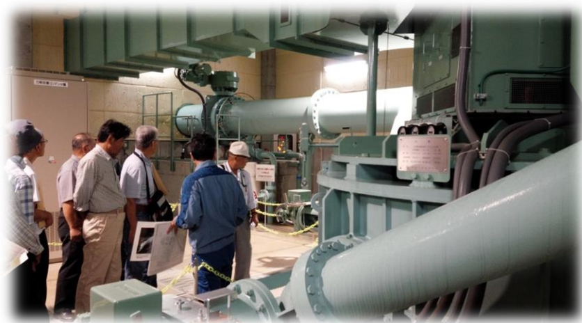
大町新堰発電所
