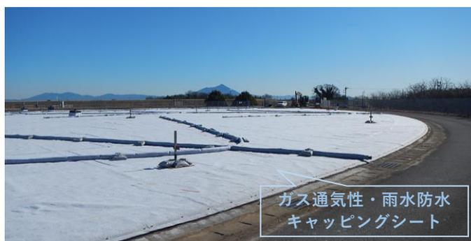
図10-1-1 シート系キャッピング工法（例）
