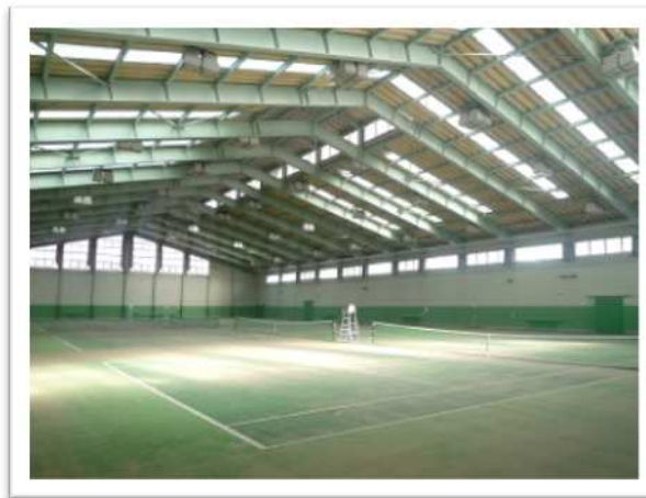
松本市南部屋内運動場
