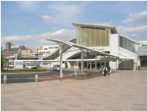
松本駅東西自由通路（アルプス口）
