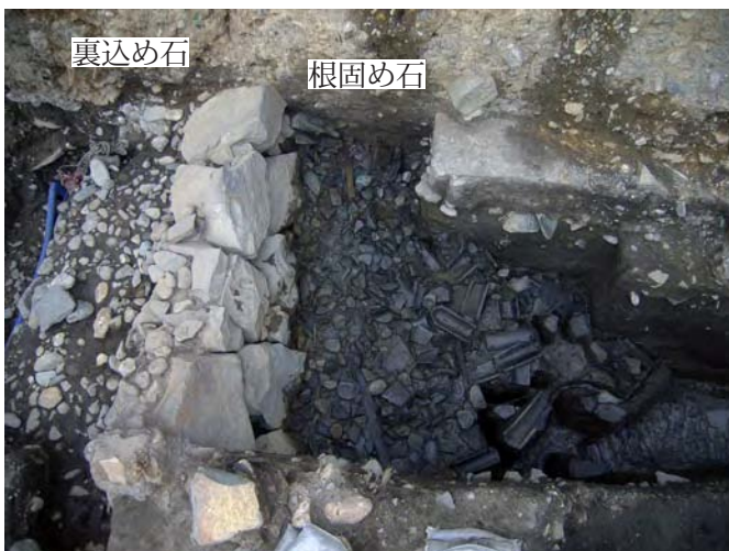
写真5 石垣前面の根固め
