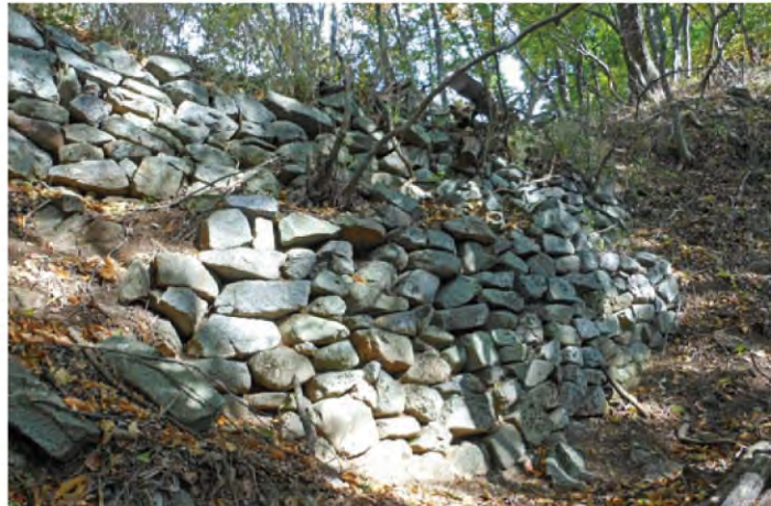
図32 埴原城主郭の石積(セットバック)
