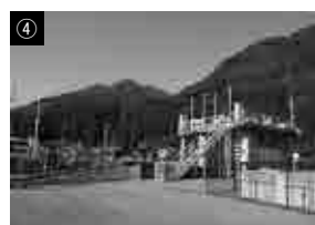
堰取水口水門
