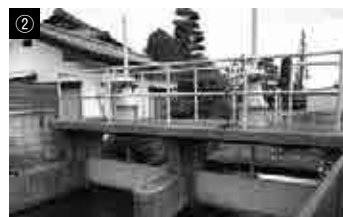
新村堰分水工
