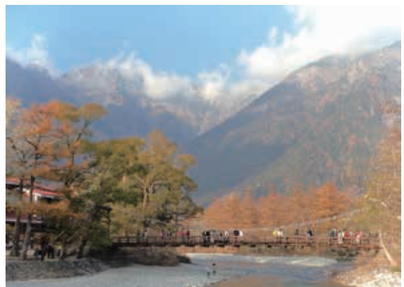
現在の吊り橋
