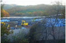
一面に積み重なった仮置き場のフレコンバッグ
