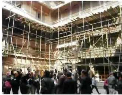
▲足場が組まれた文化財 (カトマンズ市王宮広場)
