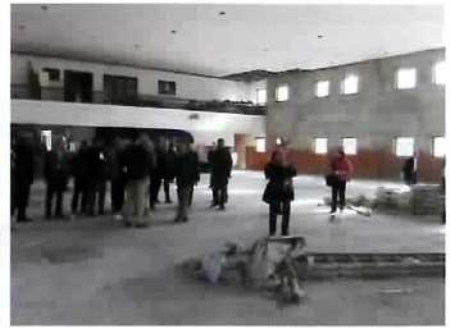
▲修復工事中の武道館 (ナヤバザー地区)
