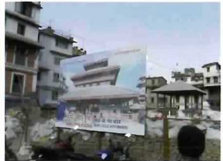
▲土台を残して崩壊した寺院 (カトマンズ市王宮広場)
