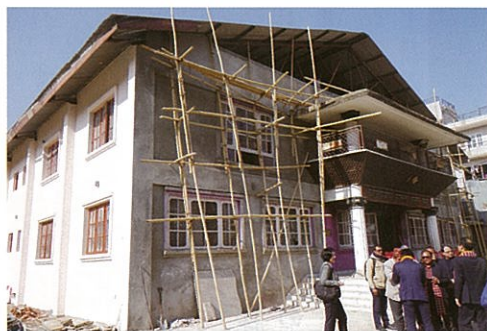
▲修復工事が進む武道館
