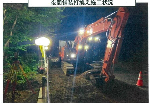
夜間舗装打換え施工状況
