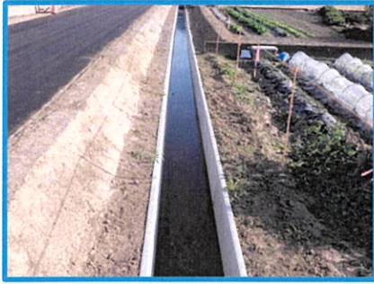
用排水路整備
