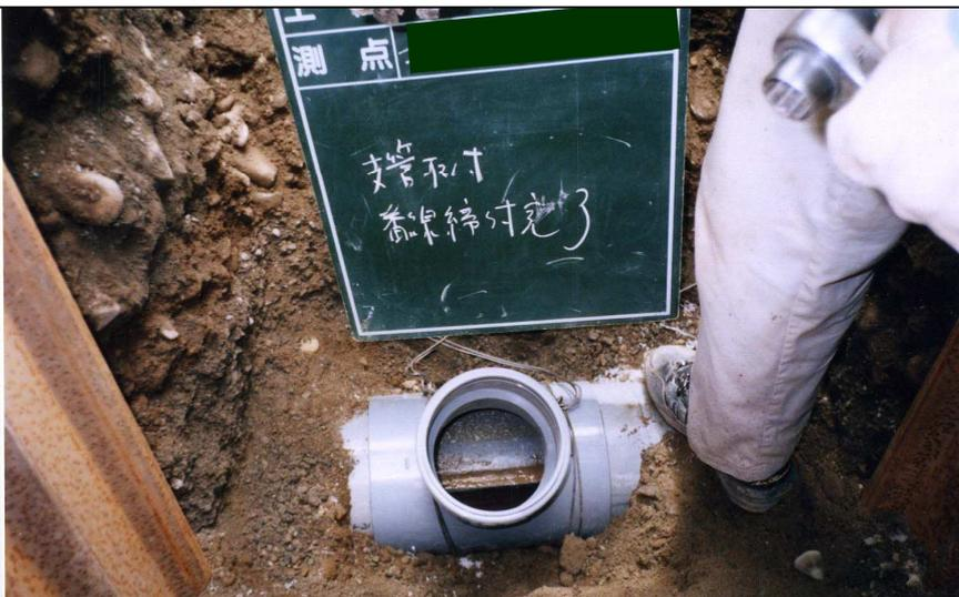
☆ 残高検測時には取付管φ150の扱い外径を170mmとしてください。
