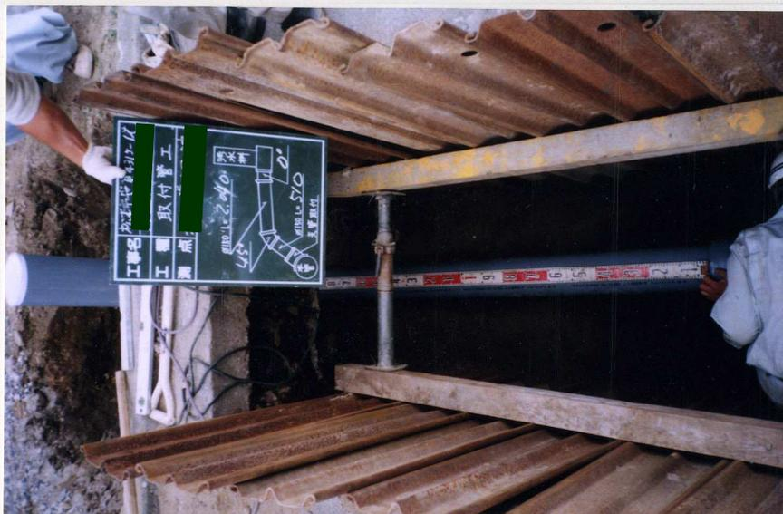
☆ 掘削側面及び他埋設管と離隔を30cm以上確保してください。
