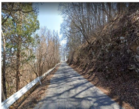
整備された林道
