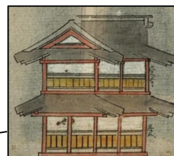
信州松本城之図部分 北西隅櫓
