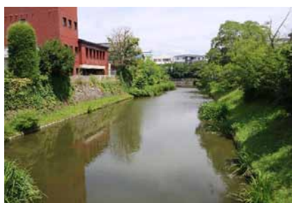
東総堀北側(南から) ★
