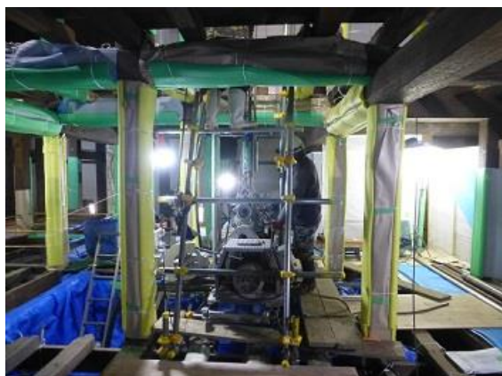
ボーリング調査(大天守内)
