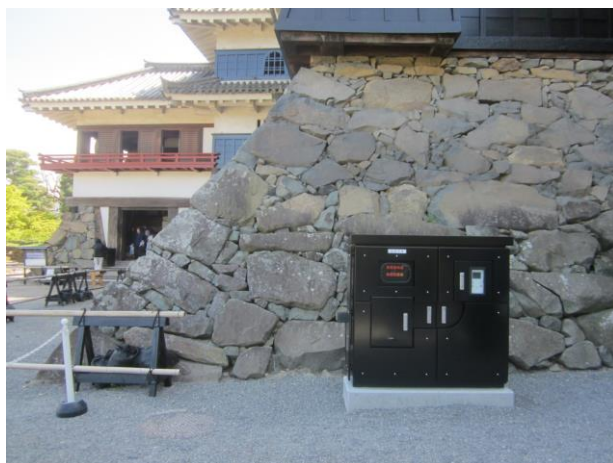
分電盤(建物内にあったものを屋外へ移設)
