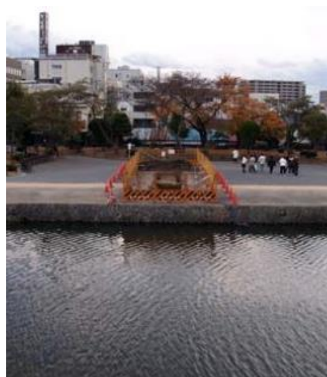
内堀の試掘調査
