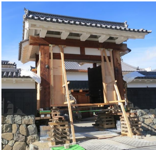
二の門の耐震工事の様子
