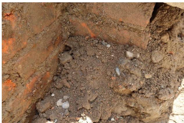
外壁接地部の砂混じりの土
