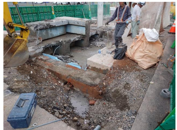
西壁面 取り壊し状況
