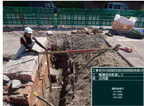
西壁面 掘削完了
