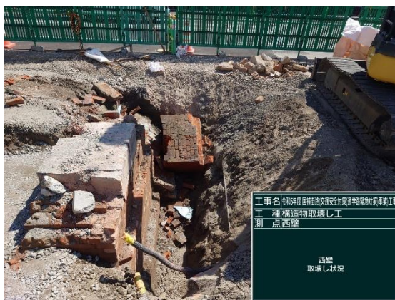
西壁面 取り壊し状況
