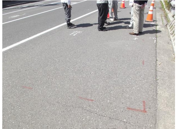
赤いラインが構造物埋設部分
