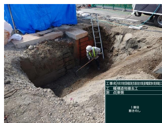
東壁面 埋め戻し
