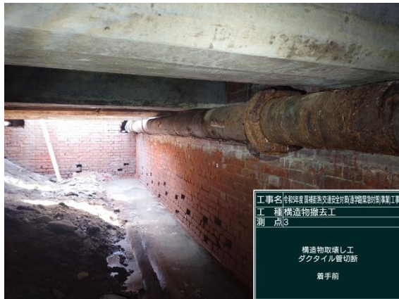
内部構造物 鋼管
