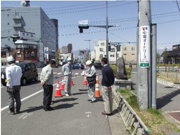
道路拡幅前 車道下部に給水
