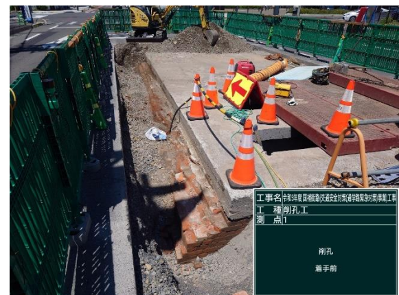
南側壁面上部
