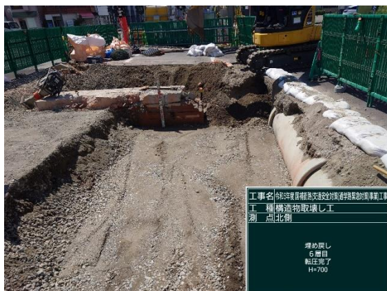
北壁面 埋め戻し
