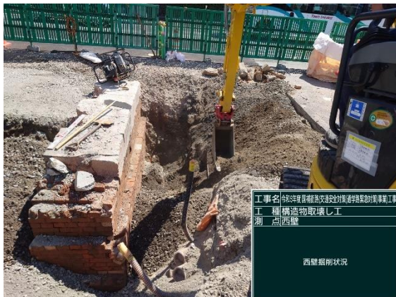
西壁面 側面掘削状況
