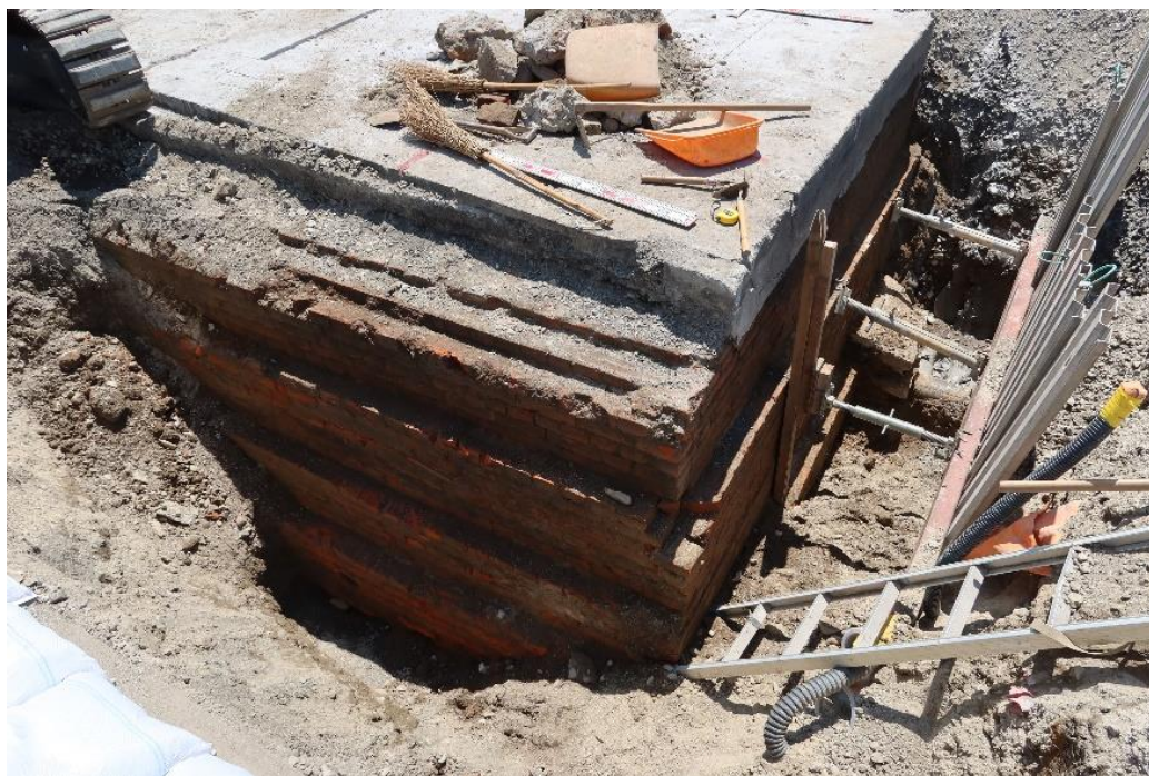
北西隠ぺい部壁面状況
