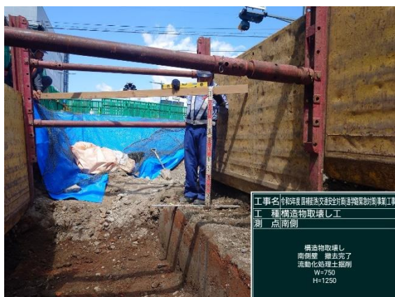
南側壁面 取り壊し完了
