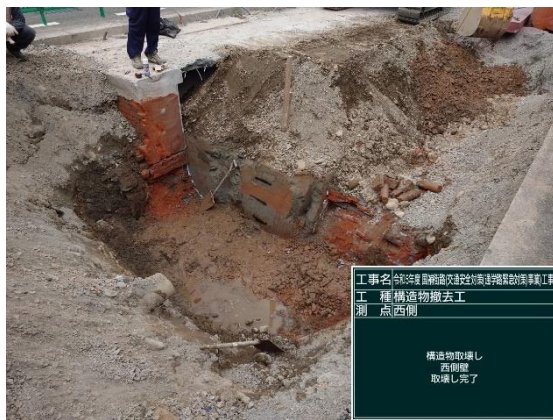
西壁面 取り壊し完了
