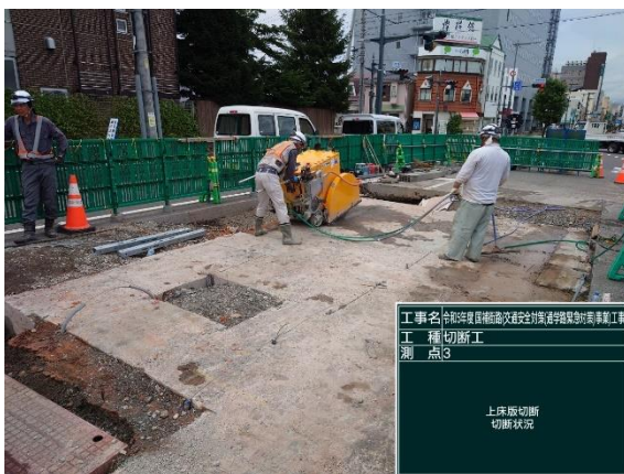
上部床版 切断状況
