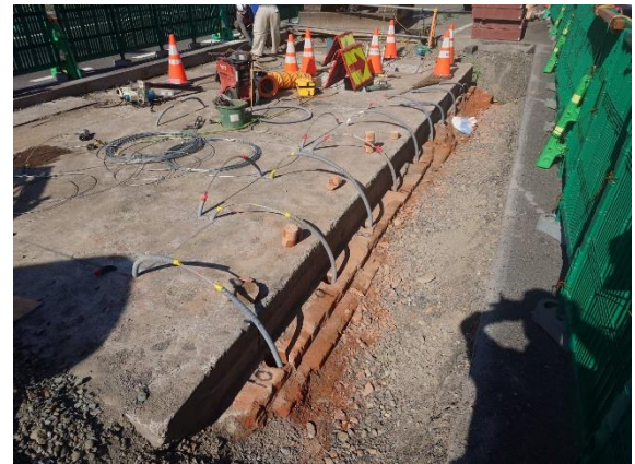
上部床版 全景
