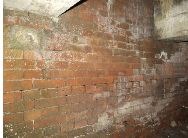
壁面レンガ積み状況
