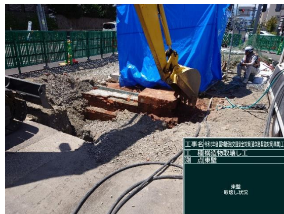
東壁面 取り壊し状況
