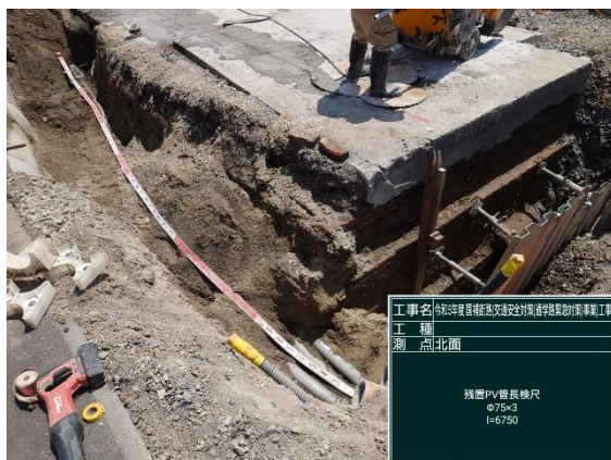
北壁面 掘削状況
