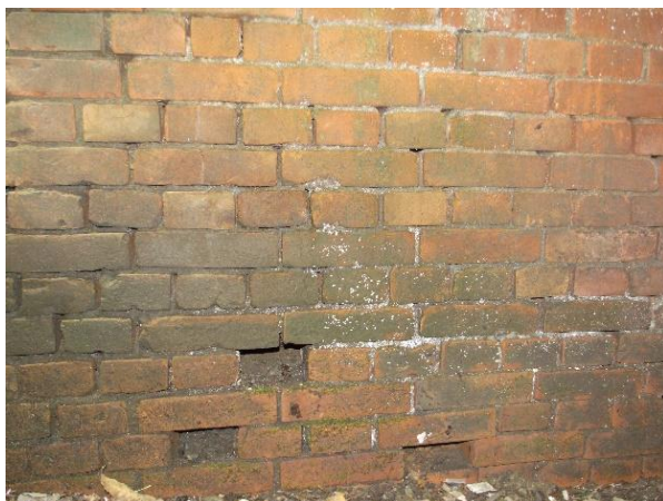
壁面レンガ積み 集水孔
