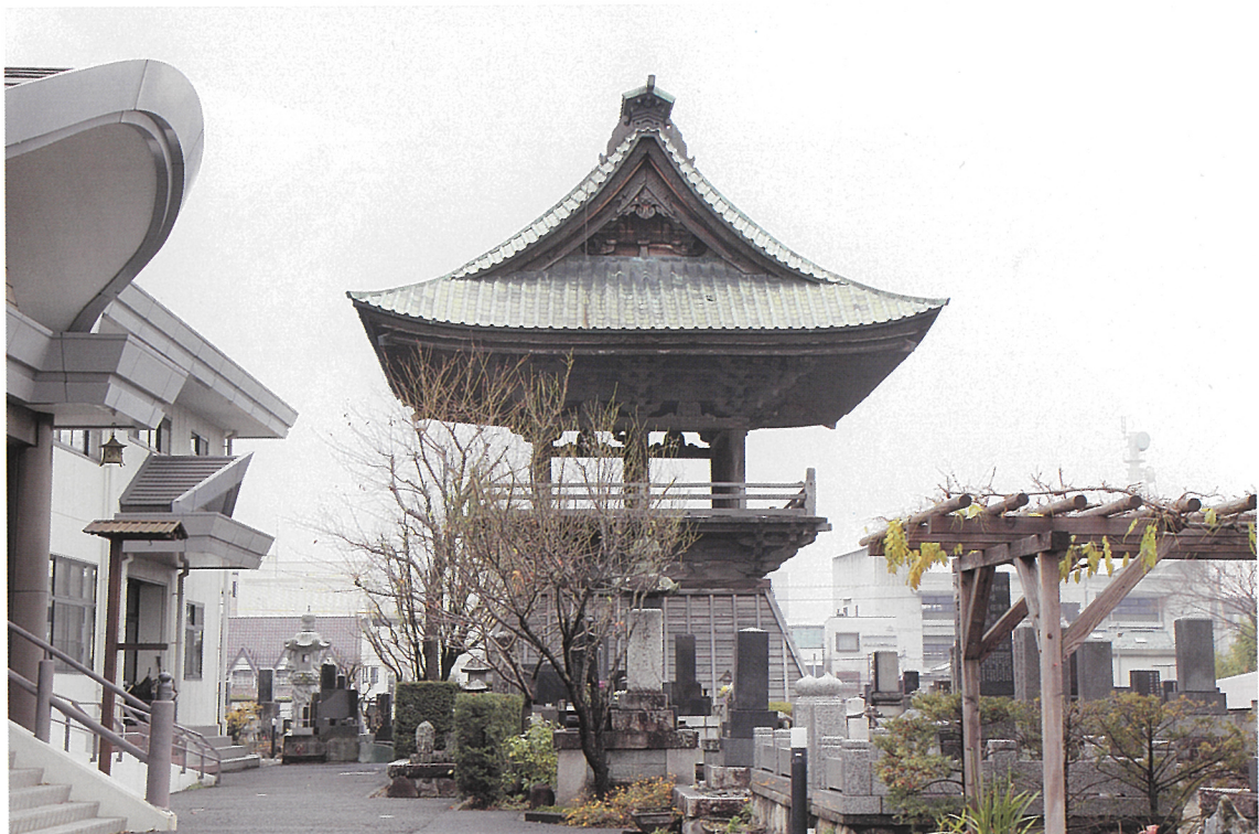
北から鐘楼を望む
