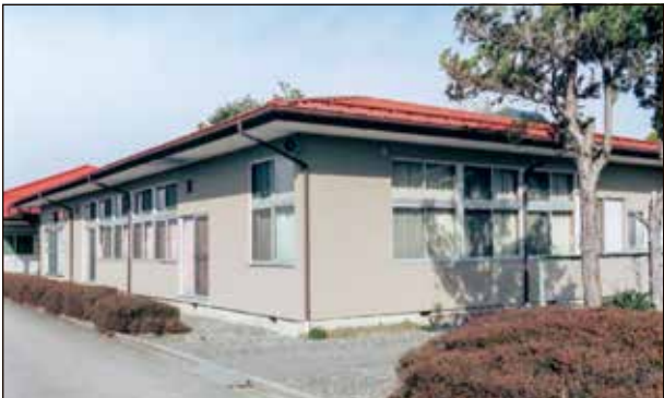
宮渕新橋公民館：松本市新橋 2 (松本市浄化センター)
